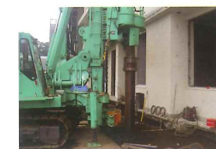
耐震補強工事
