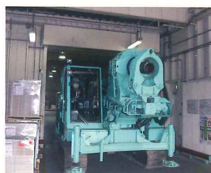
小型施工機を自走させながら搬入するエコパイル
